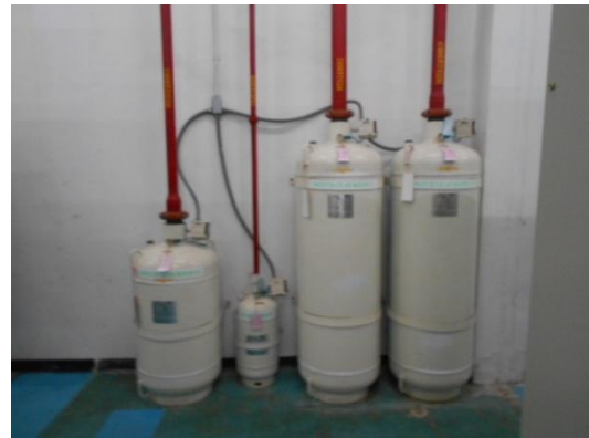
รูปที่ 3-52 Clean Agent Fire Extinguishing System (FM-200)
